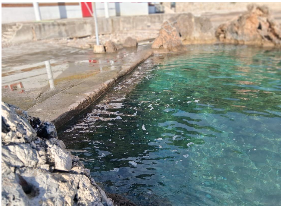
Slika 2 – dionica 2 obalnog zida od stacionaže 0+013,64 m do 0+022,81 m
