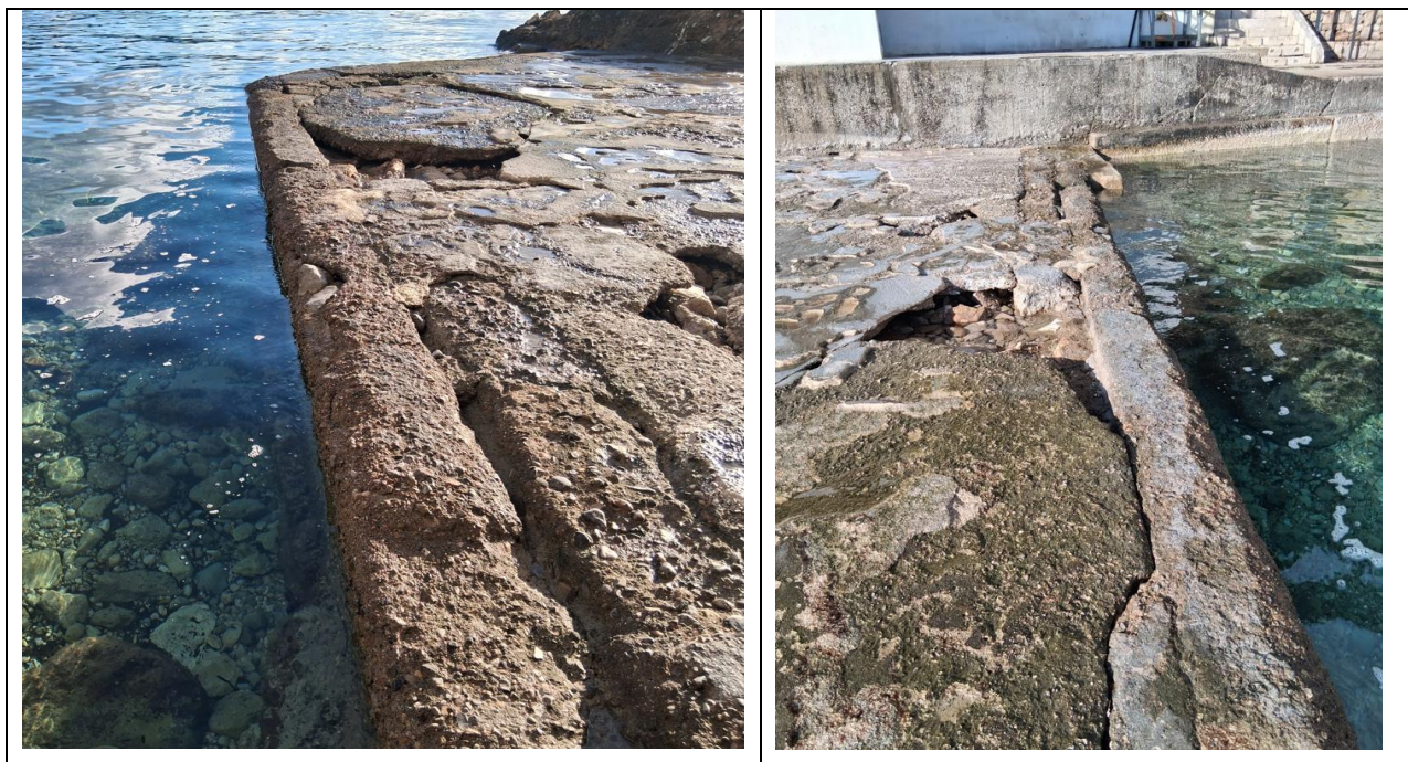
Slika 7 – dionica 3 obalnog zida od stacionaže 0+022,81 m do 0+039,22 m
