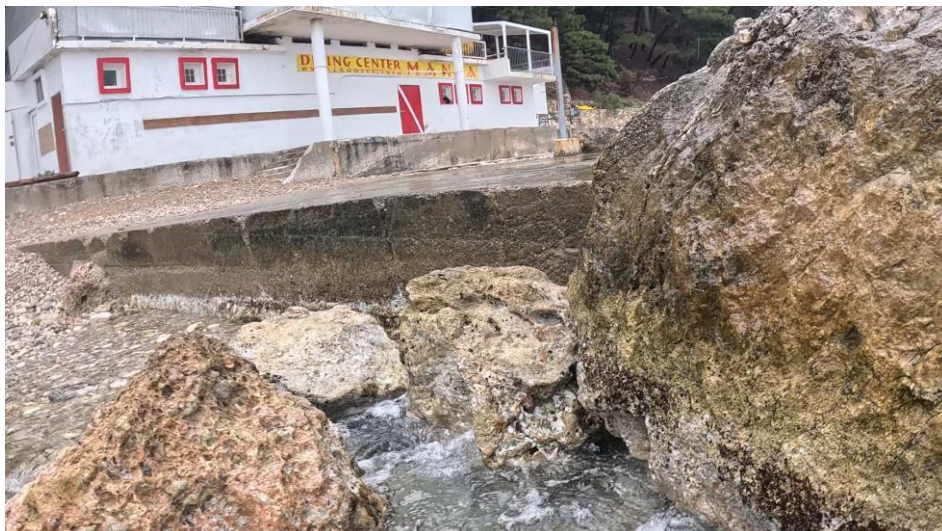
Slika 1 – dionica 1 obalnog zida, od stacionaže 0+000,00 m do 0+013,64 m
